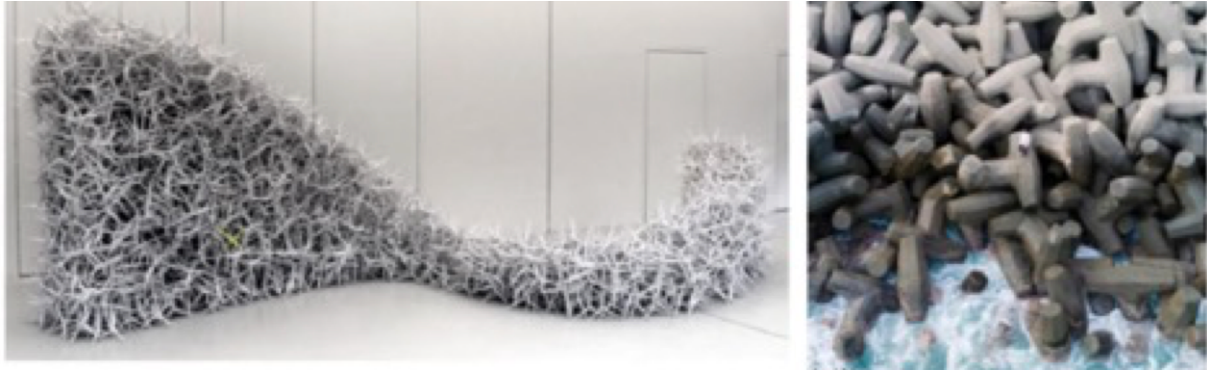
Figure 2 : (gauche) Structure granulaire composée de grains étoilés ; Credit karoladierichs.net. (droite) Exemple de digue construite avec des blocs de bétons non-convexes dans le Pas de Calais.
